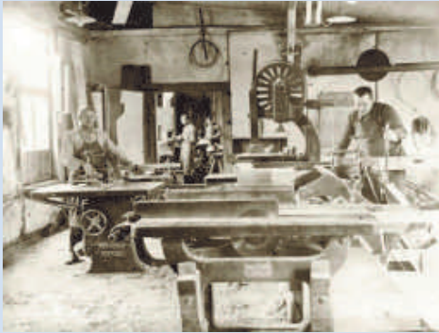
V.l.n.r.: Schreinerei, Wäscherei, Krankenstation
